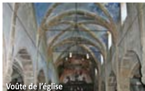
Voûte de l'église
