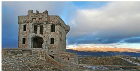
Le bétonnage nécessite 170 heures de travail ininterrompu du 10 au 17 septembre 1898, deux équipes se relayant toutes les 8 heures. 4 550 barres d'acier sont coulées dans le béton pour améliorer la résistance de l'ouvrage. Par souci d'économie, seuls les côtés exposés aux tirs ennemis sont ainsi renforcés. Le contraste avec la façade sud est saisissant. Pierres de tailles, pont-levis et fossé donnent au fort son caractère.
